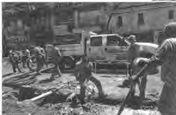
Operarios trabajan en San Luis el 30 de octubre para solucionar un desperfecto. Las tareas de la EPE para mejorar el servicio implicarán más altura de verano.
