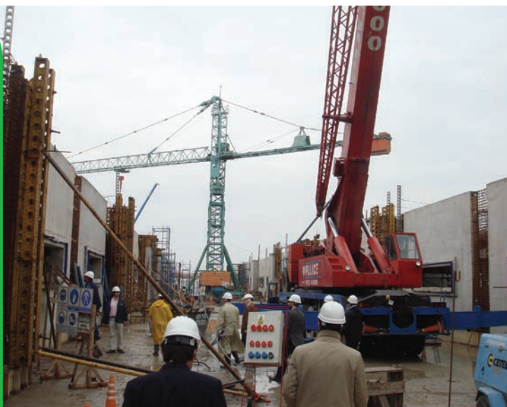
↑ Planta Bicentenario en Berazategui: obras de expansión de los servicios de saneamiento cloacal. Fuente: DPN.
