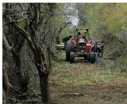
← Primeras etapas del desmonte en localidad de Fortín Dragones, Provincia de Salta. Fuente: DPN, Félix G.B..
