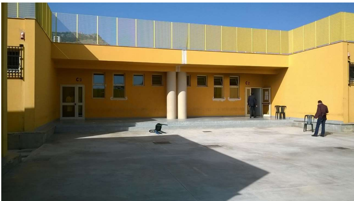
L'entrée des unités de vie
