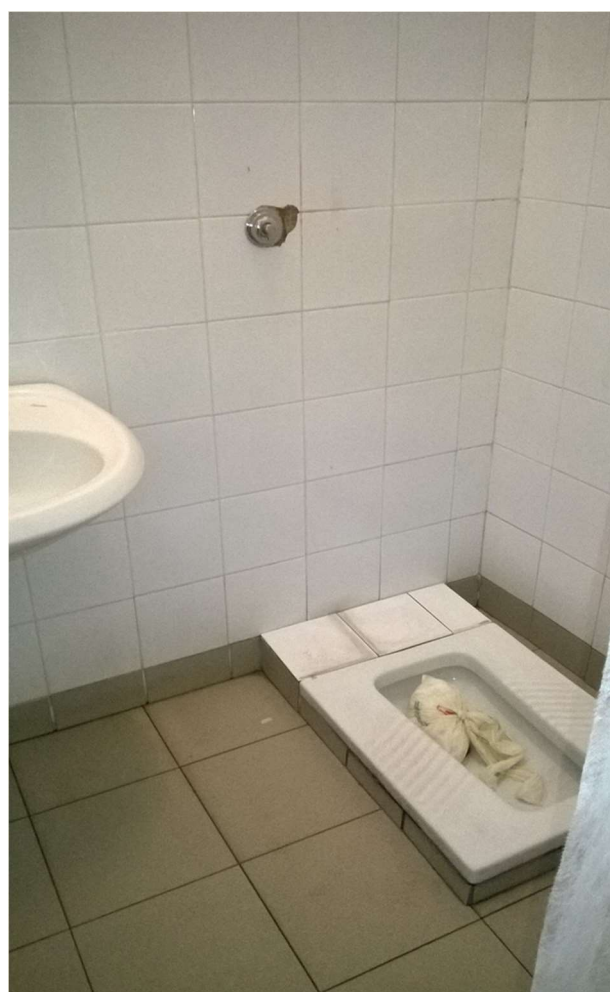
Les toilettes des unités de vie
